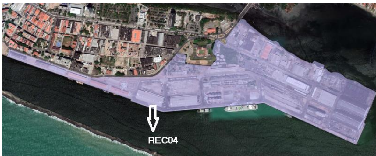
Figura 3 – Cais Norte do Porto do Recife Fonte: Elaboração própria, com base no PDZ do Porto do Recife
